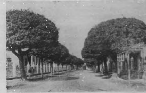
De Cárdenas.—Avenida de la Independencia.—Tramo de las Quintas.
