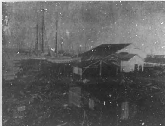
CARDENAS.—Echevarría y Ca. Vista del Astillero
