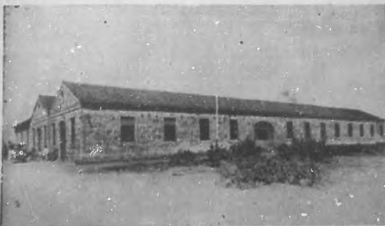
CARDENAS.—Exterior de los Talleres de Fundición y Maquinaria de la Vda. de Etchegoyen e Hijos.
