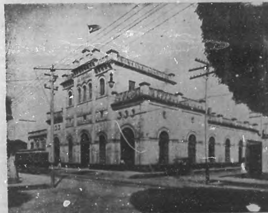
De Cárdenas.—Edificio del Cuartel de Bomberos.
