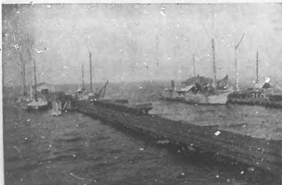
CARDENAS.—Vista del muelle propiedad de la casa Echevarría y Ca.
