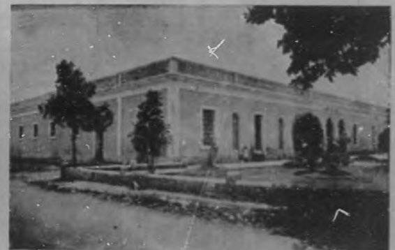
De Cárdenas.—Exterior de la Cárcel.
